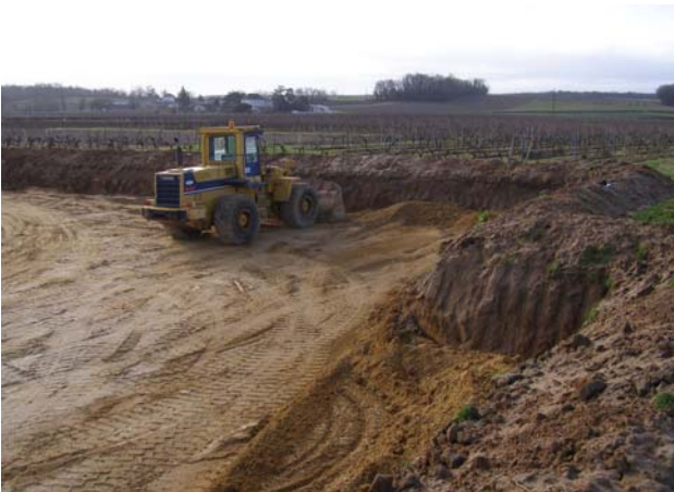
Chargeur (phase de découverte)
